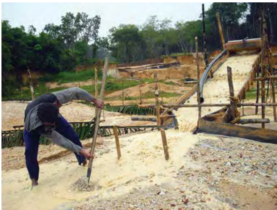
Imagem 6. Desmonte hidráulico. Por Natalia Guerrero, nov. 2011.
