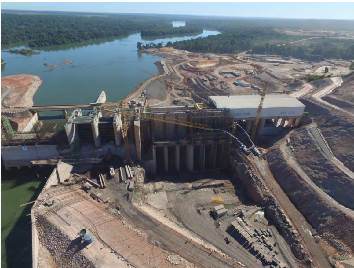
Obra da usina hidrelétrica de Sinop (Foto: PAC)
