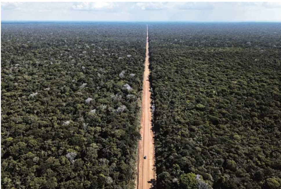
A rodovia BR-319, que liga Manaus a Porto Velho, passa por grandes áreas de floresta intacta. Na foto, de 2018, é possível ver a realização dos trabalhos de “manutenção”. Fonte: Folha de S.Paulo.
