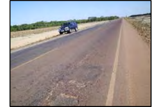
Foto 12 - Estado de conservação do pavimento
