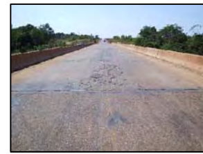
Foto 82 - Ponte em concreto
