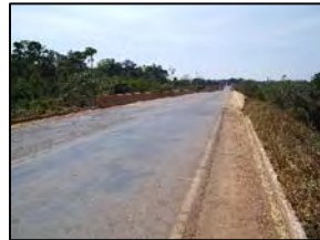
Foto 78 - Ponte em concreto
