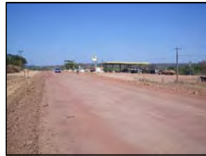
Foto 157 - Travessa urbana de Terra Nova
