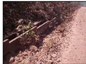
Foto 205 - Detalhe de dispositivo de drenagem (corte plano em rocha)
