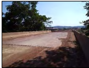
Foto 156 - Início de trecho em asfalto
