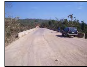
Foto 194 - Ponte em concreto
