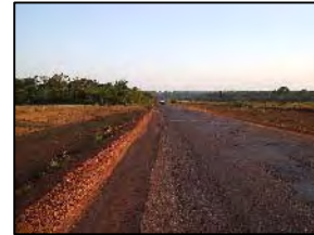
Foto 117 - Estado de conservação do pavimento
