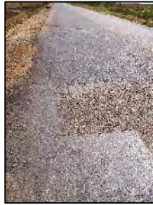
Foto 54 - Estado de conservação do pavimento
