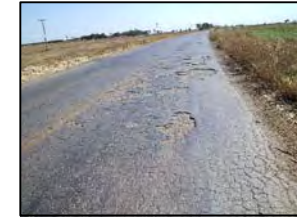
Foto 52 - Estado de conservação do pavimento (TSD)
