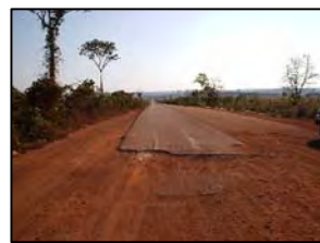
Foto 147 - Vista geral (início do asfalto)
