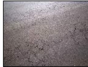
Foto 10 - Estado de conservação do pavimento
