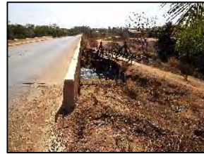
Foto 66 - Ponte em concreto
