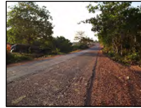
Foto 113 - Detalhe da vegetação e do estado de conservação do pavimento
