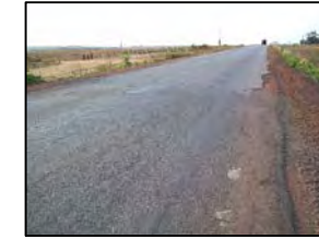
Foto 119 - Estado de conservação do pavimento
