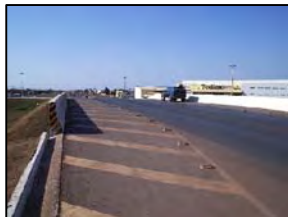
Foto 96 - Viaduto sobre avenida principal de Sinop
