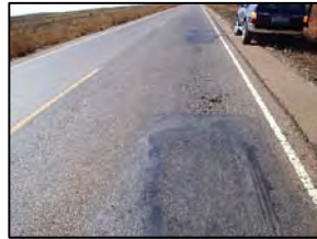
Foto 9 - Estado de conservação do pavimento
