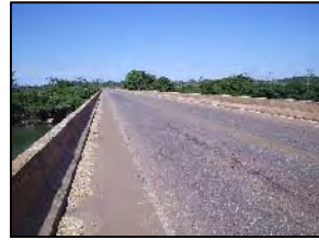
Foto 58 - Ponte em concreto
