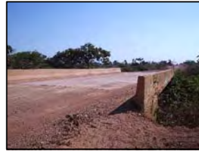
Foto 159 - Ponte em concreto
