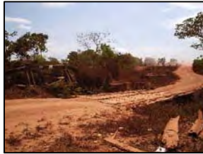
Foto 208 - Detalhe de pontilhão improvisado
