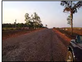
Foto 116 - Estado de conservação do pavimento
