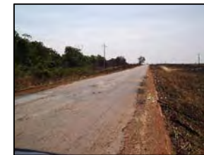
Foto 75 - Estado de conservação do pavimento
