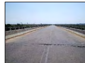
Foto 174 - Ponte em concreto
