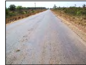
Foto 71 - Estado de conservação do pavimento
