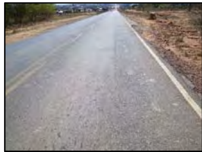
Foto 172 - Estado de conservação do pavimento
