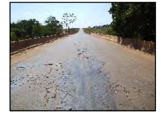
Foto 84 - Ponte em concreto
