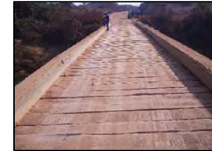
Foto 341 - Ponte em madeira
