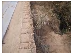
Foto 318 - Pontilhão construído sobre OAC metálica
