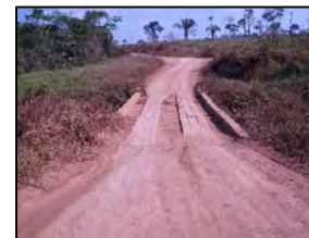
Foto 384 - Ponte em madeira
