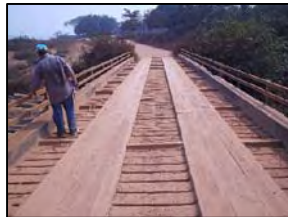
Foto 350 - Primeira ponte em madeira
