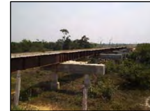
Foto 364 - Ponte mista em construção. Atualmente a travessia se dá através de balsa
