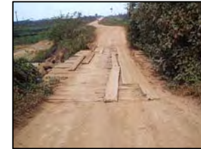
Foto 369 - Ponte em madeira
