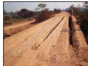
Foto 343 - Ponte em madeira
