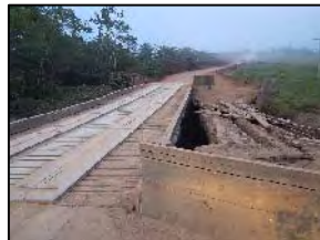
Foto 330 - Detalhe de ponte de madeira construída ao lado de ponte destruída
