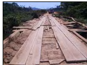
Foto 367 - Ponte em madeira
