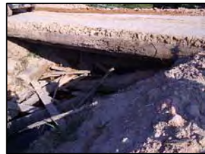
Foto 391 - Ponte em madeira
