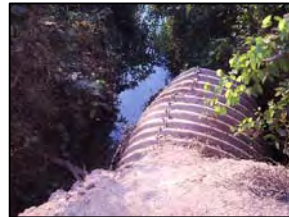
Foto 339 - Detalhe de buelro metálico
