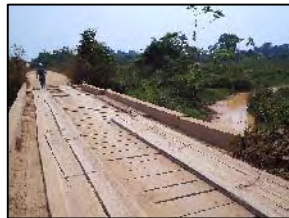
Foto 362 - Ponte em madeira
