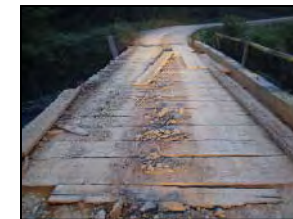
Foto 408 - Ponte em madeira
