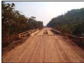
Foto 338 - Ponte em madeira
