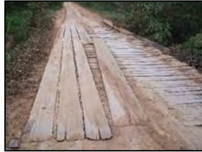
Foto 418 - Ponte em madeira
