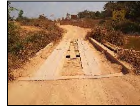
Foto 376 - Ponte em madeira
