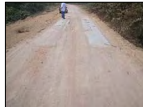
Foto 319 - Pontilhão construído sobre OAC metálica
