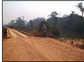
Foto 347 - Ponte em madeira
