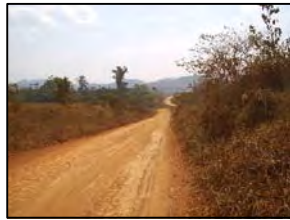
Foto 370 - Vista geral com detalhe de desvio a direita
