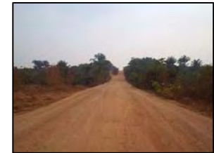
Foto 261 - Vista geral (notar desvio a esquerda)
