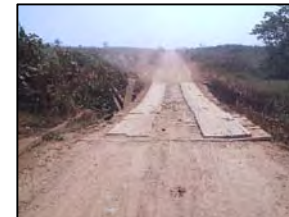
Foto 276 - Ponte em madeira
