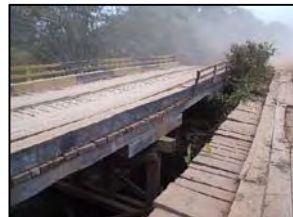
Foto 326 - Ponte de madeira construída ao lado de ponte destruída
