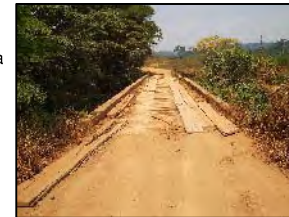
Foto 372 - Ponte em madeira
