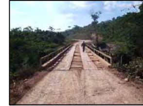
Foto 389 - Ponte em madeira
