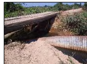
Foto 296 - Ponte de madeira construída onde havia OAC
