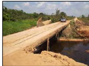
Foto 294 - Ponte de madeira onde havia OAC
