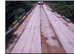
Foto 425 - Ponte em madeira
