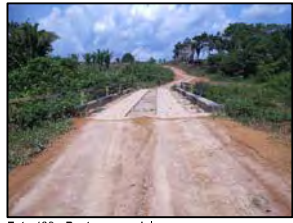
Foto 439 - Ponte em madeira
