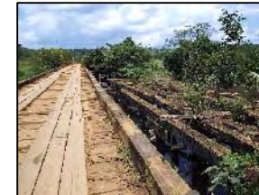
Foto 469 - Ponte em madeira
