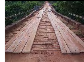
Foto 556 - Ponte em madeira
