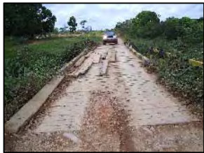
Foto 422 - Ponte em madeira
