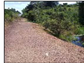
Foto 580 - Detalhe de descida d'água metálica
