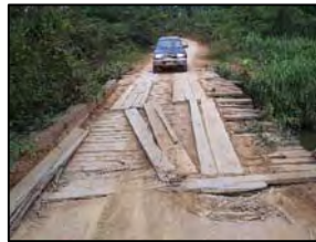
Foto 420 - Ponte em madeira
