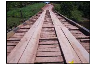
Foto 621 - Ponte em madeira
