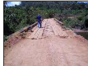
Foto 468 - Ponte em madeira
