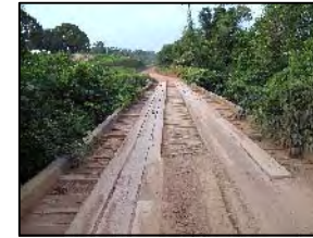
Foto 482 - Ponte em madeira
