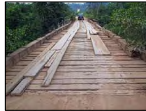
Foto 535 - Ponte em madeira
