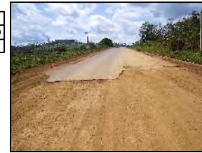
Foto 470 - Início de segmento pavimentado
