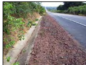
Foto 579 - Detalhe de sarjeta
