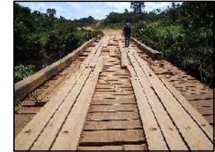
Foto 467 - Ponte em madeira
