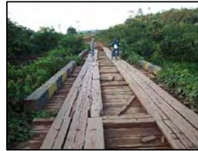
Foto 455 - Ponte em madeira
