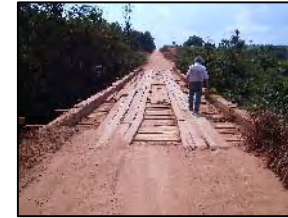
Foto 538 - Ponte em madeira
