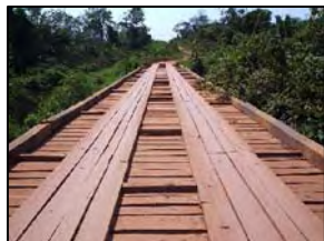
Foto 523 - Ponte em madeira
