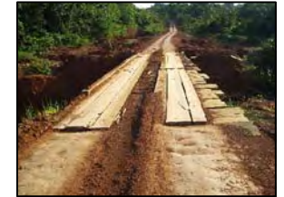
Foto 449 - Ponte em madeira
