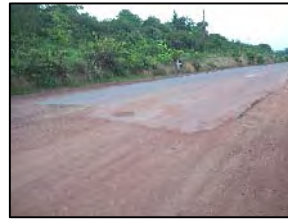
Foto 575 - Início do asfalto
