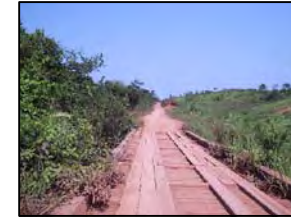
Foto 520 - Ponte em madeira
