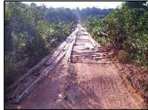
Foto 564 - Ponte em madeira
