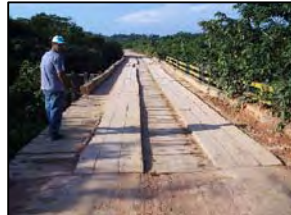
Foto 447 - Ponte em madeira
