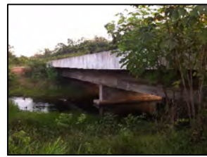
Foto 570 - Ponte em concreto
