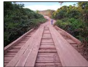
Foto 487 - Ponte em madeira
