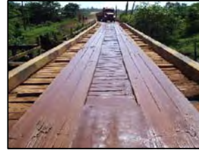
Foto 461 - Ponte em madeira
