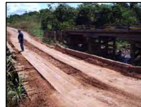
Foto 623 - Ponte em madeira
