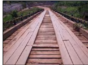
Foto 529 - Ponte em madeira
