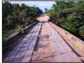
Foto 481 - Ponte de madeira
