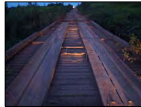
Foto 491 - Ponte em madeira
