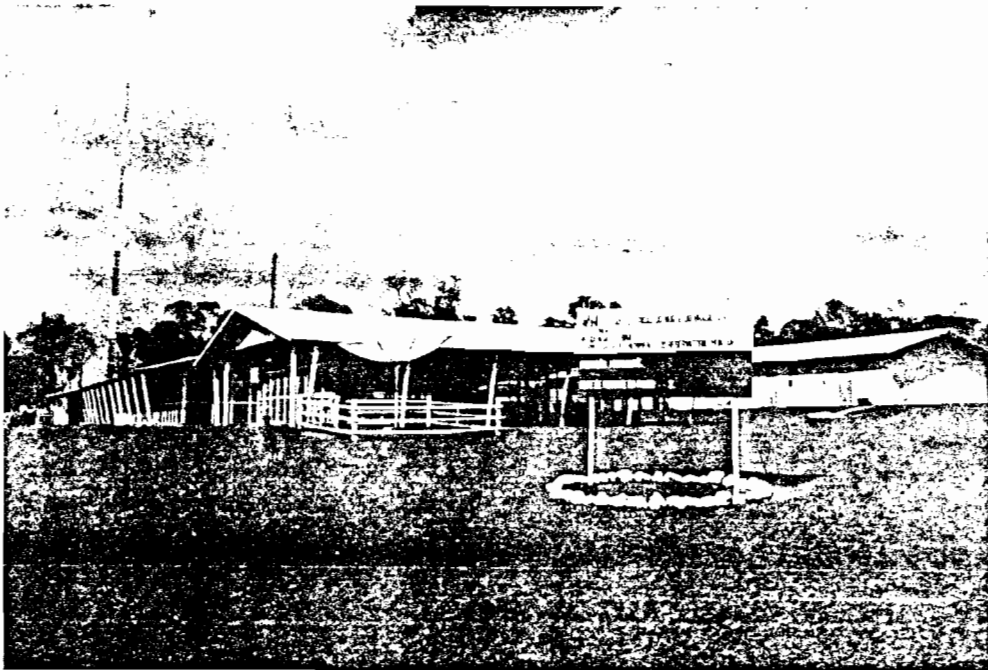
Vista parcial da Base de Resgate II - Instalações definitivas.
