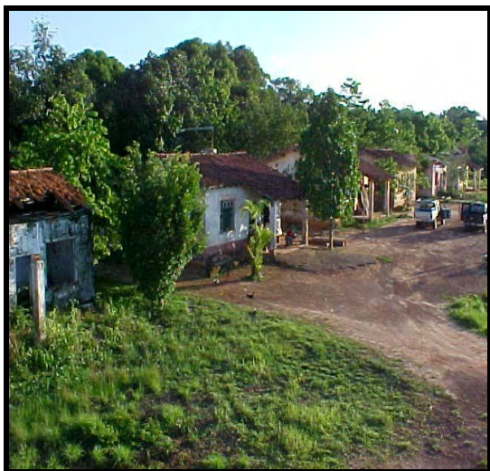
FOTO B.IV. 211 – Sítio Vila Ferroviária de Jirau: conjunto de residências, Km133/ BR-364
