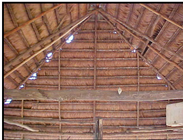
Detalhamento da cobertura em palha / Casa de Farinha
