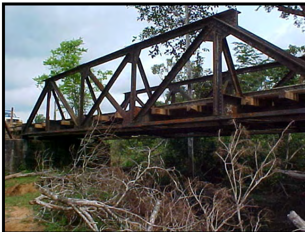
FOTO B.IV. 215 – Sítio Primavera – ponte metálica, em treliça, localizada sobre o rio Trinta, no ramal Primavera
