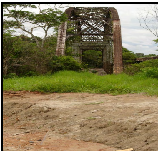
FOTO B.IV. 229 – Ponte metálica sobre o rio Jaci-Paraná
