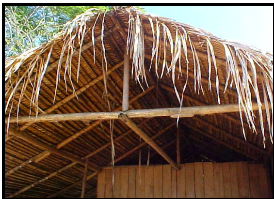
Cobertura de palha e madeiras
