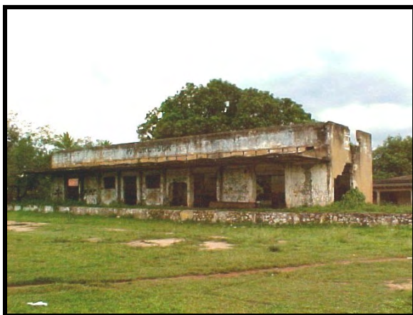
FOTO B.IV. 225 – Ruínas da Estação ferroviária – Jaci-Paraná
