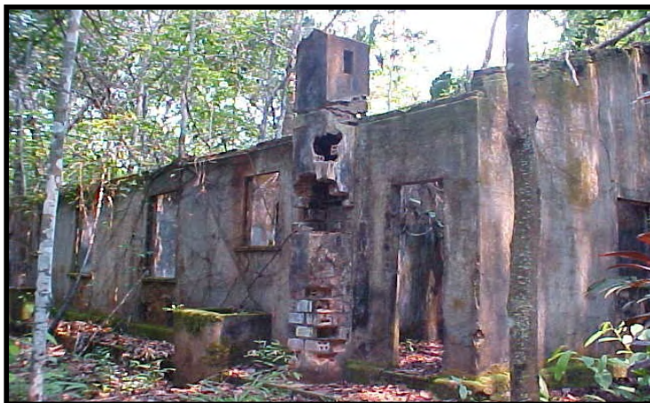
FOTO B.IV. 216 – Sítio Cisca Folha: ruínas de residências da Vila Ferroviária, Km 202 da ferrovia, ramal Cisca Folha.
