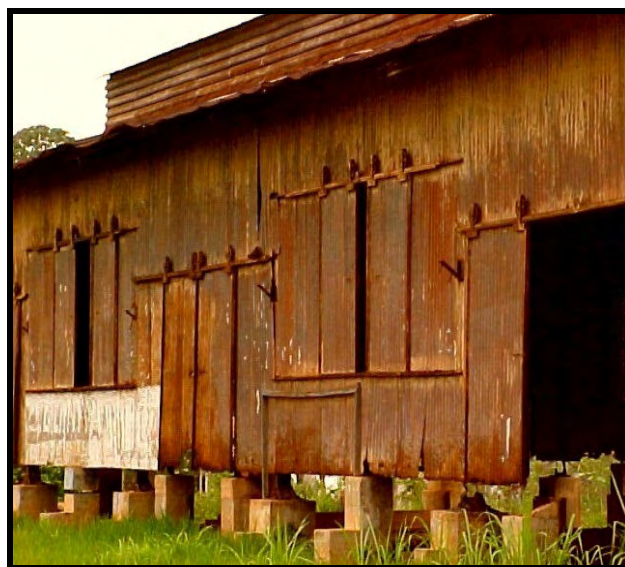
FOTO B.IV. 218 – Galpão da ferrovia EFMM em Abunã, com cobertura e laterais em chapas metálicas.
