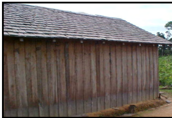
Casa em madeira jacaruba e telhado em cavacos de ipê
