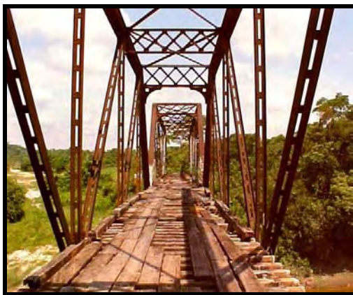
FOTO B.IV.213 – Sítio Mutum-Paraná: Ponte metálica em treliça sobre o rio Mutum-Paraná.
