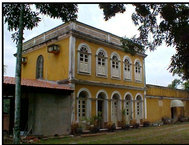
FOTO B.IV. 223 – Casa dos Ingleses, vista do pátio interno
