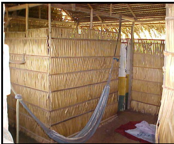
Divisão interna de casa com paredes de palha
