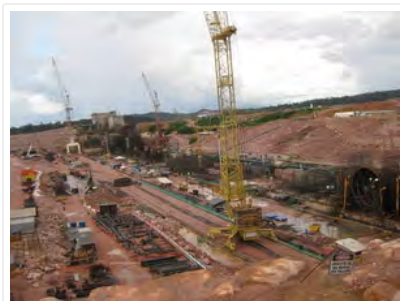
Panorâmica das obras na represa de Jirau. Foto: Mario Osava / IPS
